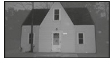
5933 Valencia Blvd, Lansing ***
