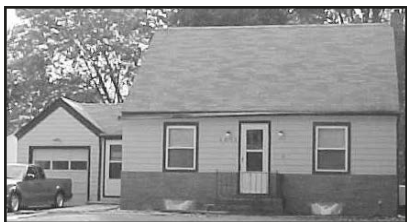
6013 Valencia Blvd, Lansing ***
