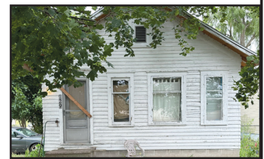
Property 3351 - Lansing 229 S. Detroit St.
