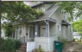
Property 3323 - Lansing 918 Shiawassee St.
