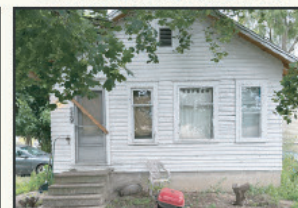
Property 3351 - Lansing 229 S. Detroit St.
